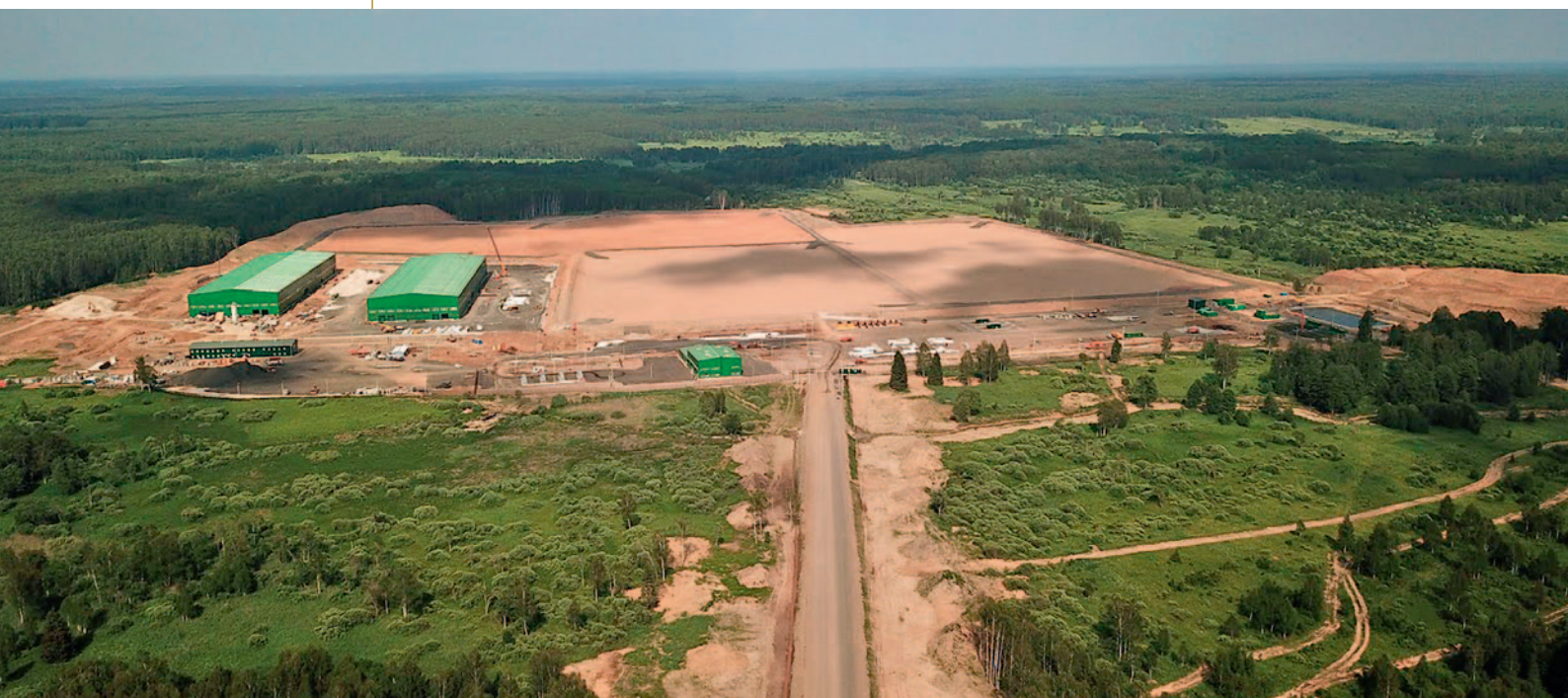
Рис. 10. Стройплощадка «ЭкоТехноПарк «Калуга».
