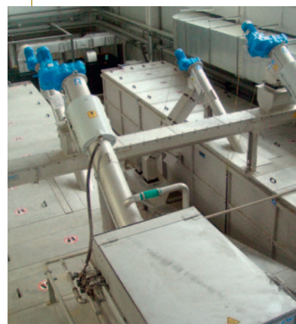
Очистные сооружения поселения Птичное.
