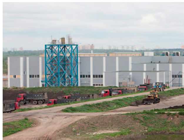
Рис. 2. Завод по производству гипохлорита натрия
