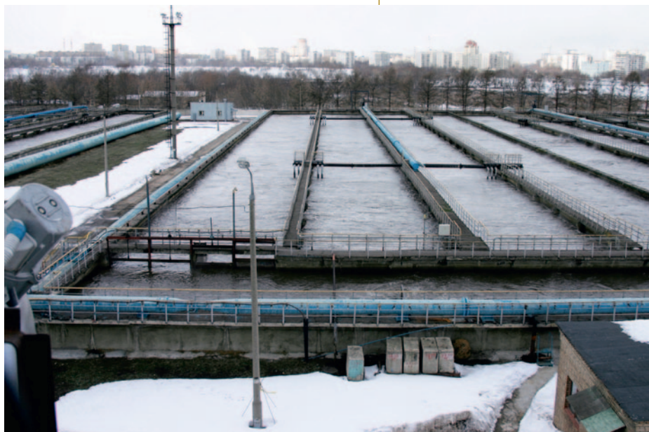
Рис. 4. Аэротенки Курьяновской станции аэрации города Москвы
