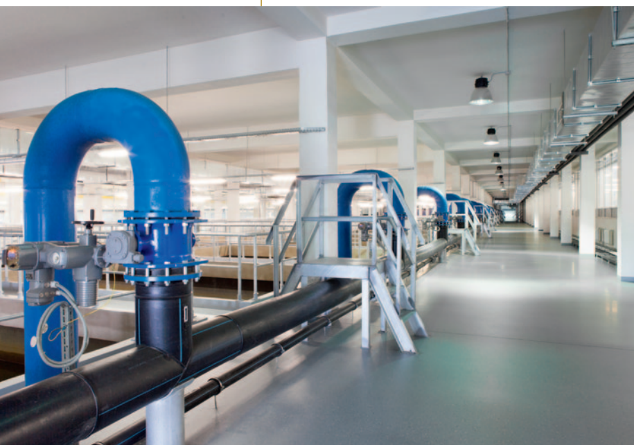
Рис. 1. Зал фильтров Западной водопроводной станции Москвы
