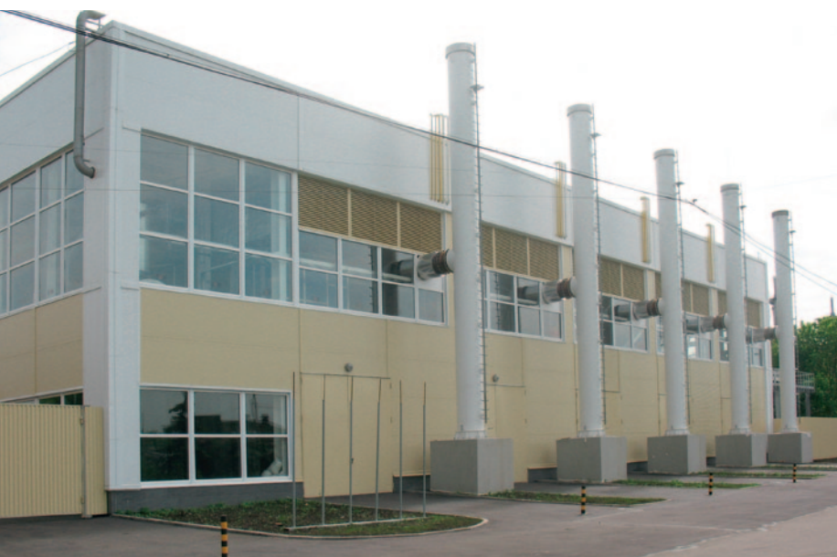
Рис. 7. Мини-ТЭС на Курьяновских очистных сооружениях города Москвы
