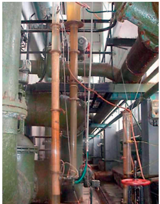
Рис. 3. Станция кондиционирования подземных вод города Жуковский
